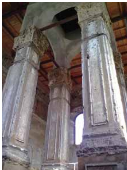
Wnętrze nieczynnej synagogi w Rymanowie.
